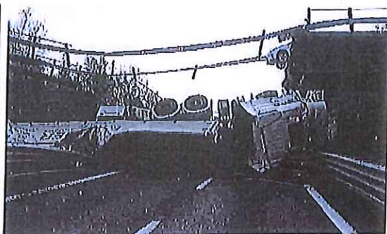
Il ponte crollato in Valassina
