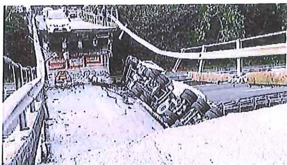
Il ponte di Annone crollato lo scorso 28 ottobre 2016
