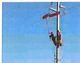
Villa Peduzzi lavori di Enel possibili disagi
